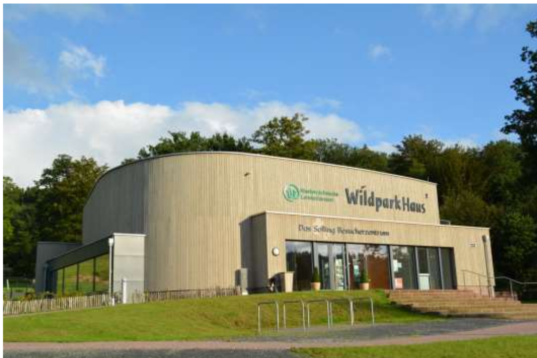
Abb. 37 WildparkHaus – Das Solling-Besucherzentrum
